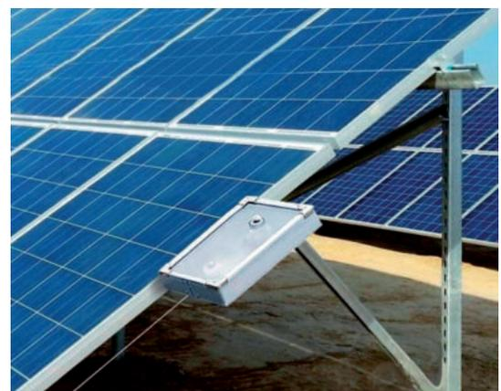
Se puede montar en la parte superior o lateral del panel fotovoltaico o entre ellos, o en paneles fotovoltaicos de uno o varios ejes.
