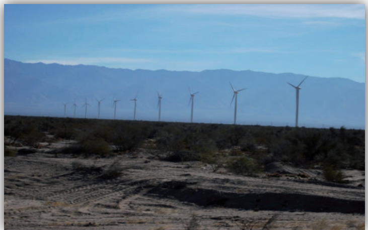
Campo de aerogeneradores, Catamarca, Argentina
